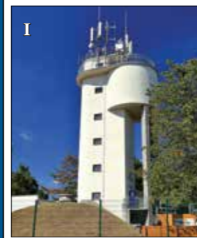
1 Vodojem Kostelčec v Třebíči
