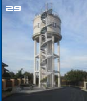
vodárenská věž v Heřmanově Huti
