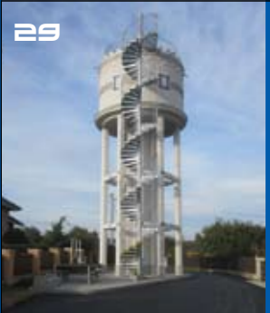
vodárenská věž v Heřmanově Huti
